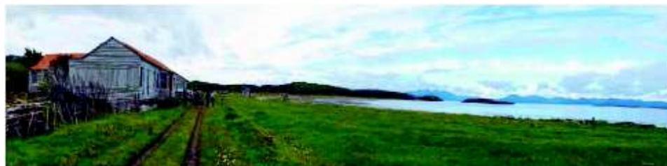
Etat du bâtiment avant restauration en 2009.
