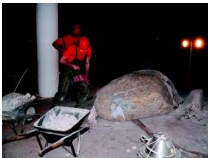
Une ambiance de mine... quand les hommes de la PC ont attaqué le bloc erratique: il a fallu 3 jours au marteau piqueur et l'utilisation de «dynamite douce» pour réussir à diviser le bloc erratique, posé avec la grue de chantier avant le coulage de la dalle du rez-de-chaussée en 1976. Les morceaux ont été extraits du Musée afin de permettre le passage à cet endroit.
