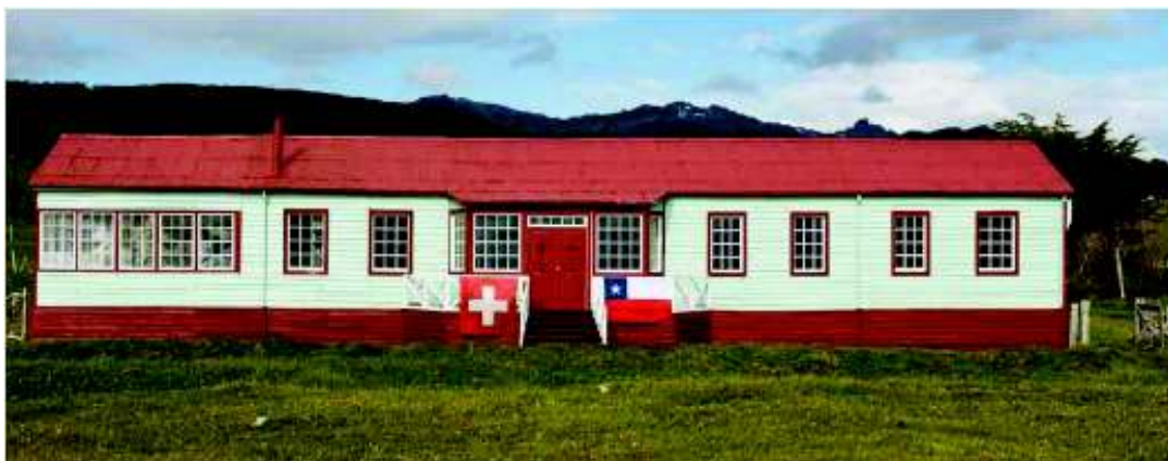
Bâtiment restauré. Typique de l'architecture coloniale de Patagonie. Les différents espaces naissent de la nécessité de se protéger du vent et du froid avec des matériaux que la nature offre sur place
