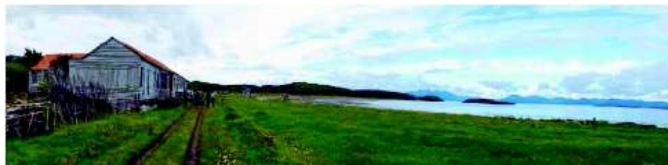
Etat du bâtiment avant restauration en 2009.
